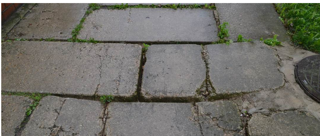
13. att. – betona plākšņu iesēdums pie kanalizācijas akas
