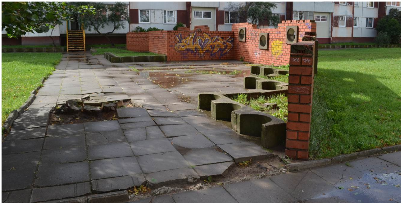
11. att. – Aprakstītā dekoratīvā siena ar daļēji sabrukušu betona plātņu segumu kopumā veido vidi degradējošu iespaidu
