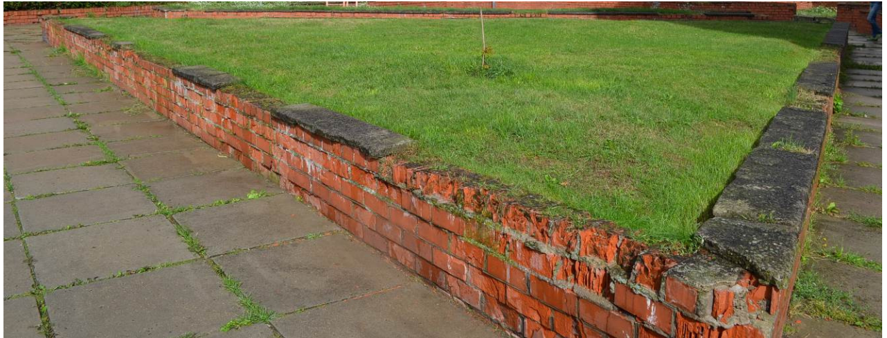
10. att. – Dekoratīva platforma ar daļēji sabrukušiem betona pārsegumiem un augšējām mūra rindām
