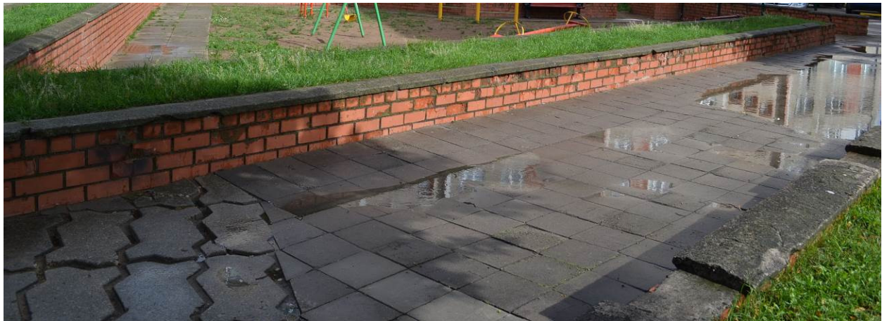
6. att. – Seguma plātņu izcilājumi un iesēdumi pie mūra atbalstsienas
