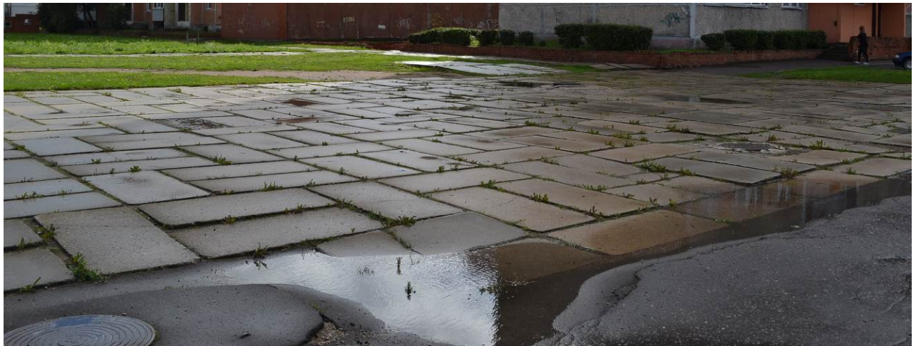
8. att. – Segumu salaiduma zona, kurā radies virsmas iesēdums
