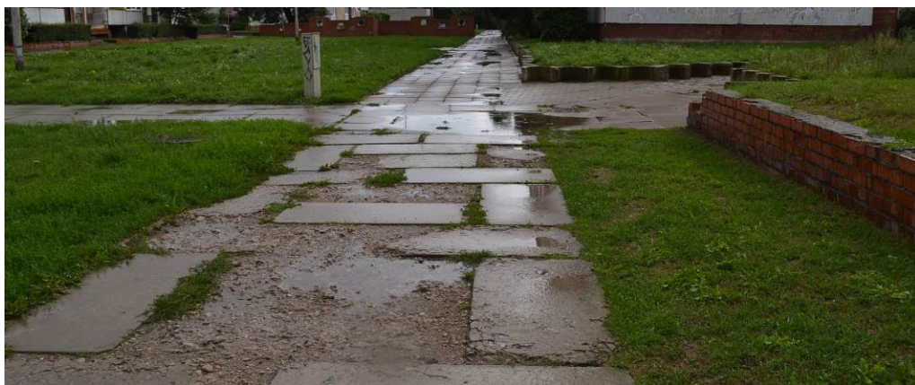
3. att. – Atsevišķiem celiņa posmiem konstatēti lieli betona izdrupumi
