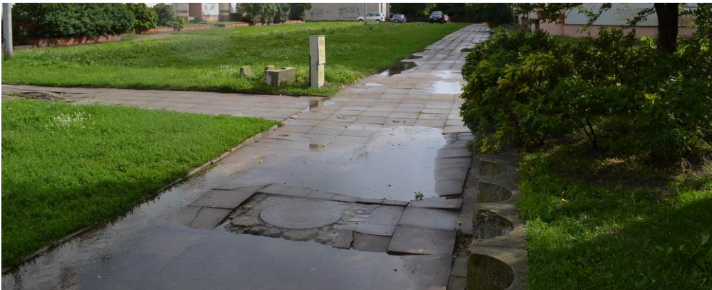
12. att. – betona plākšņu iesēdums pie kanalizācijas akas
