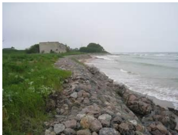
7. attēls Erozijas krasta stiprinājumi ar gabioniem pie Liepājas NAI
