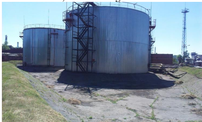
3.attēls. Virszemes rezervuāru parks
