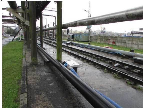
2.attēls. Pretinfiltrācijas segums dz/estakādē
