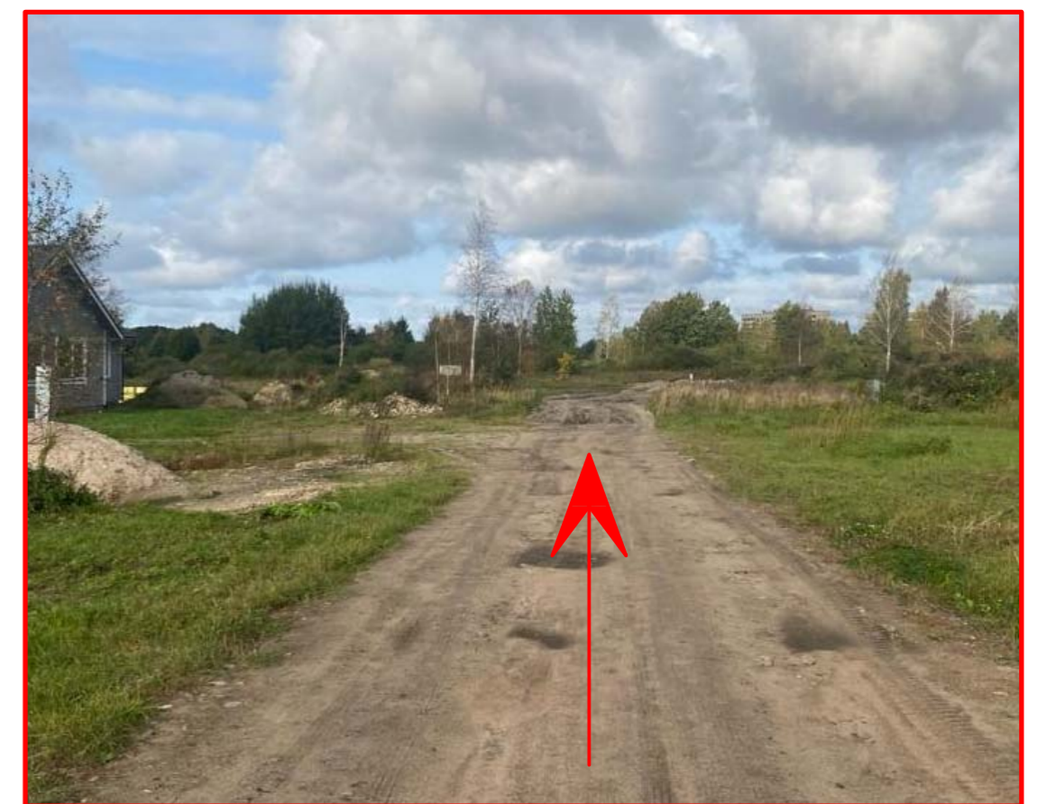
Skats uz pārbūvējamo ielu no Magoņu ielas virzienā uz Grīzupes ielu
