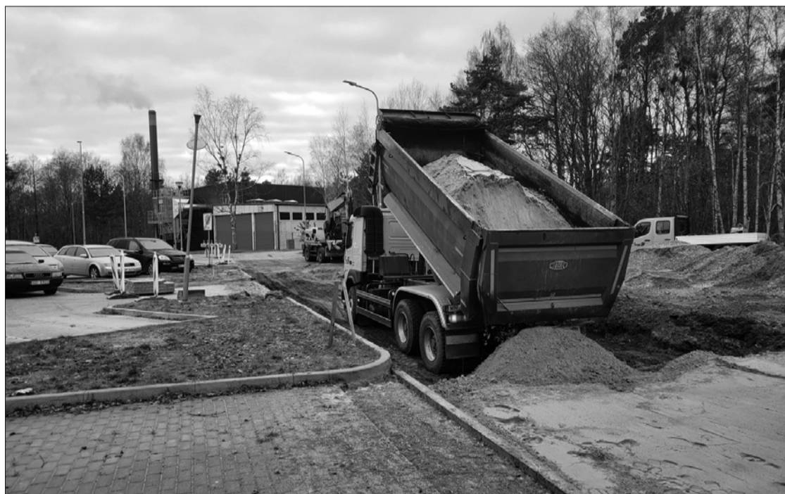
Būvdarbi Slimnīcas ielas iekšpagalmā. Iepriekšējos gados daudzdzīvokļu ēku īpašnieki šeit ir labiekārtojuši visu iekšpagalmu. Tagad te pašvaldība pārbūvē piebraucamo grants un grants seguma ceļu ar asfalta klājumu, sakārto lietus ūdens atvadi un veic citus papildu uzlabojumus. Aigara Štāla foto
