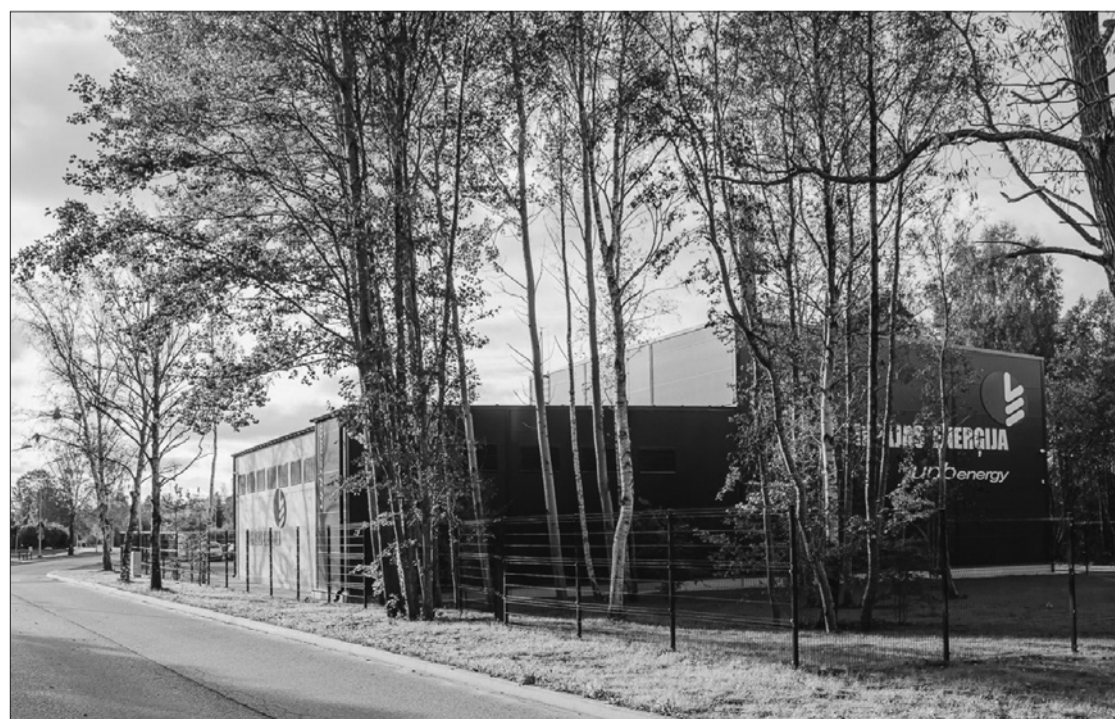
Pašvaldības kapitālsabiedrības SIA "Liepājas enerģija" jaunā šķeldas noliktava un katlu māja Slimnīcas ielā 2, lai atteiktos no gāzes apkures izmantošanas slimnīcai un tās tuvējā rajonā.
