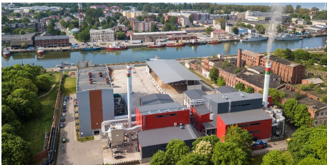
3.10.attēls. Koģenerācijas stacija Kaiju ielā 33 (autors: Liepājas valstspilsētas pašvaldība)
