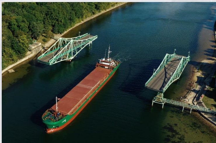
O.Kalpaka tilta VADULU izbūve Karostas kanāla sanācijas projekts
