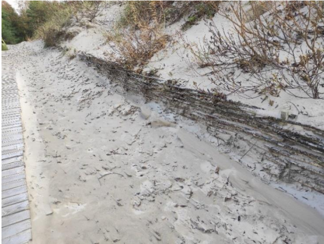
10.attēls. Kāpas nostiprinājums ar klūgu pinumu pie koka laipas.
