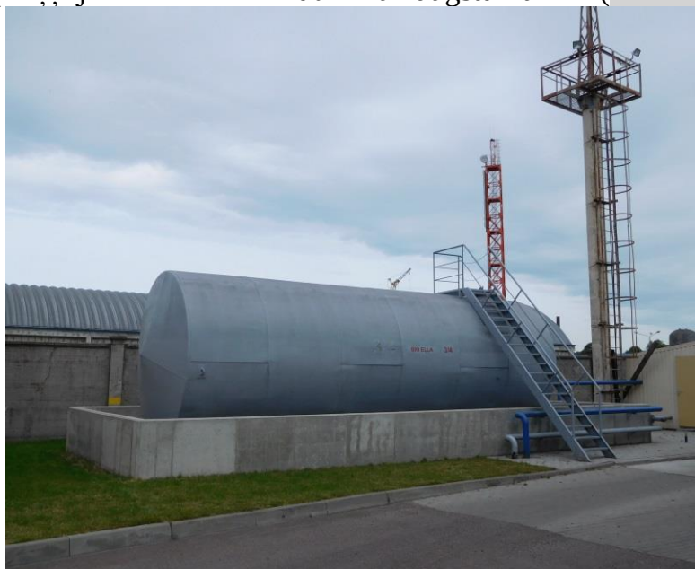
4.attēls. Rezervuārs biodīzeļdegvielas uzglabāšanai
