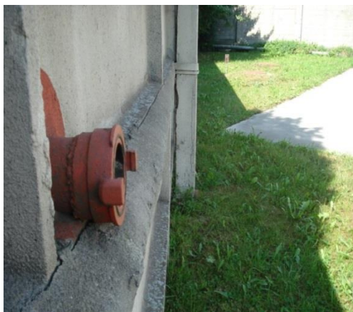
26.attēls. Teritorijas dienvidrietumu malas sētā iebūvētā ugunsdzēsības šļūteņu savienotājgalviņa
