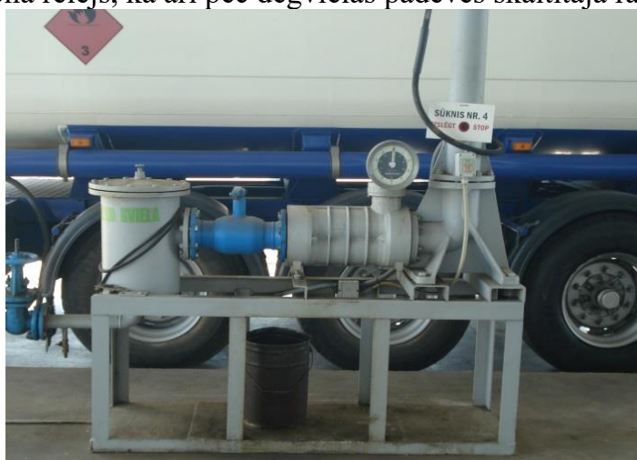
15.attēls. Autocisternu automātiskā uzpildes iekārta ASN-SIGMA
