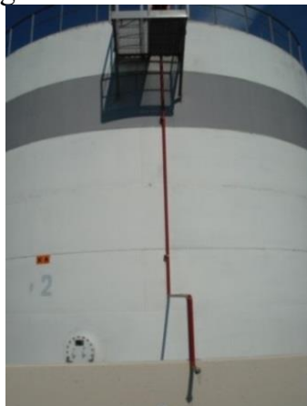
31.attēls. Stacionārais putu ģenerators ar pievadcauruli un savienotājgalviņu galā
