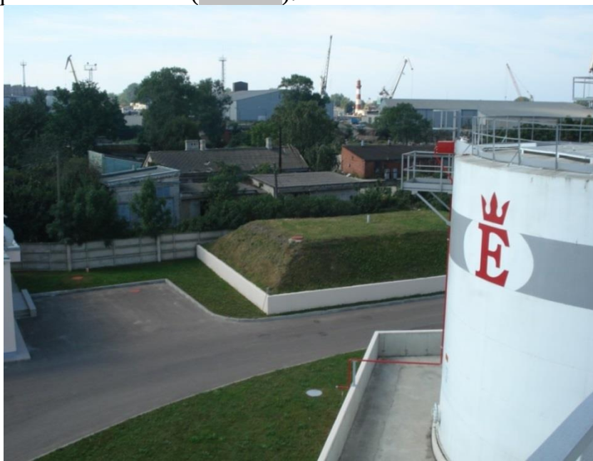
24.attēls. Ugunsdzēsības ūdenskrātuve ( V=400 \text{ m}^3 ) termināļa teritorijā un akas ūdens ņemšanai ugunsdzēsības vajadzībām
