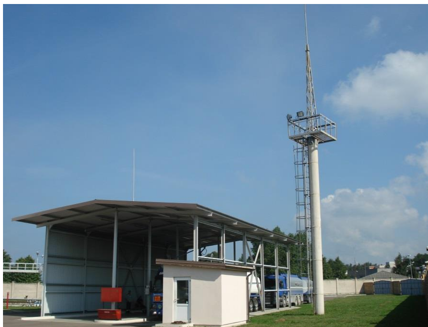
14.attēls. Autocisternu uzpildes postenis ar operatoru ēku
