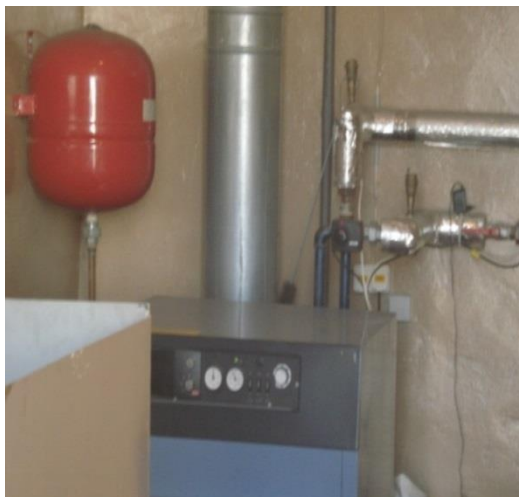
28.attēls. Šķidrā kurināmā apkures katls HSOTRAM
