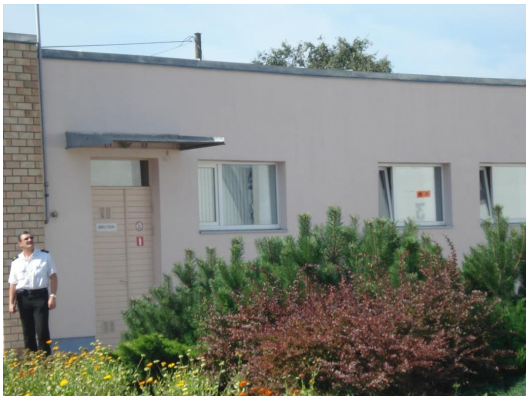
16.attēls. Administrācijas un sadzīves ēkas fragments ar ieeju katlu telpā
