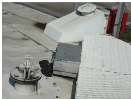
31.attēls. Stacionārais putu ģenerators ar pievadcauruli un savienotājgalviņu galā
