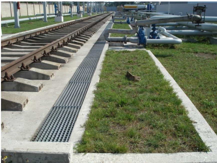
8.attēls. Pievadceļš ar rūpniecisko notekūdeņu lietuss ūdens drenāžas sistēmu
