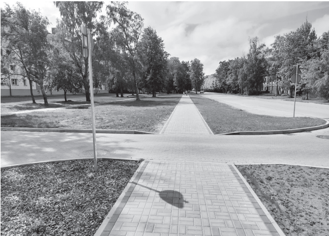
На бульваре Атмодас от улицы Катедралес до поворота на Северный мол обустроены новые автостоянки у магазинов, пешеходный переход с необходимыми знаками безопасности дорожного движения, остановка общественного транспорта и озеленение.
