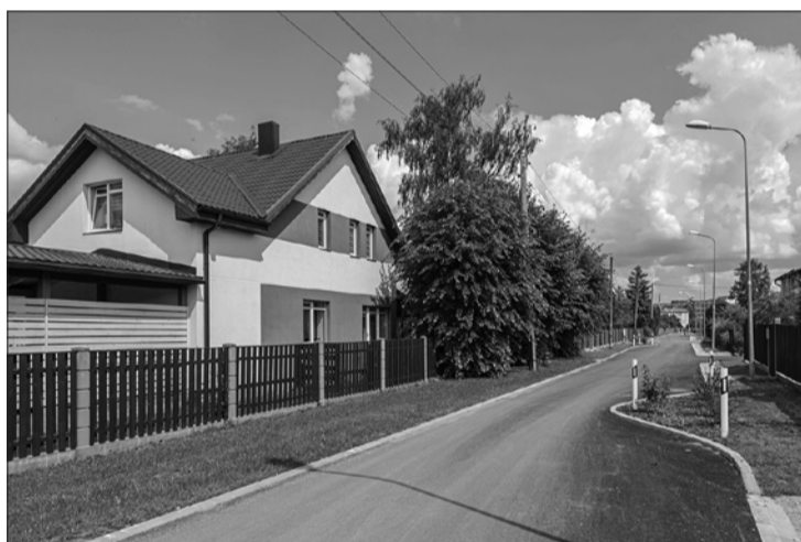
Pārbūvētā Ploču iela ieguvusi asfalta segumu, kā arī ātruma ierobežošanai izbūvētas salīņas ar stādījumiem.
