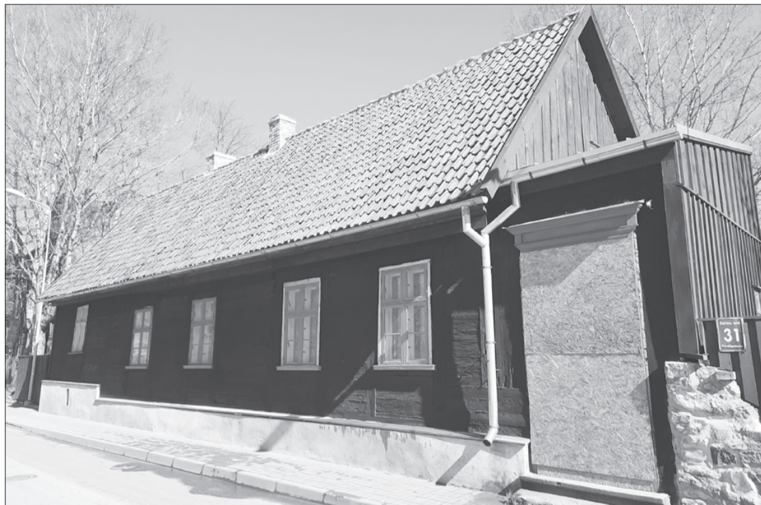
Bāriņu ielā 31. Šogad turpināsies un tiks pabeigts šis no 18. gadsimta saglabājušās mazās koka ēkas fasāžu un jumta restaurācijas būvprojekts (5. kārtā). Pašvaldības apstiprinātais līdzfinansējums ir 3854 eiro. Iepriekšējos gados ir restaurētas ārdurvis, logi, melni darvotā fasāde, sarkanā māla dakstiņu jumts un konstrukcijas, kā arī ir pārmūrēti skursteņi.
