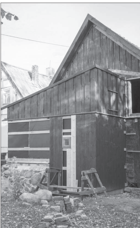
Bāriņu iela 31. Šeit notiek fasādes un piebūves restaurācija pagalma pusē.
