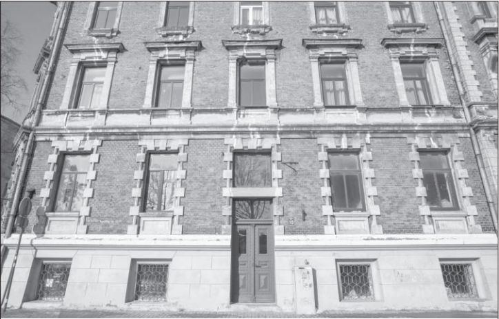
Restaurētās ārdurvis ēkas fasādē Republikas ielas pusē.
