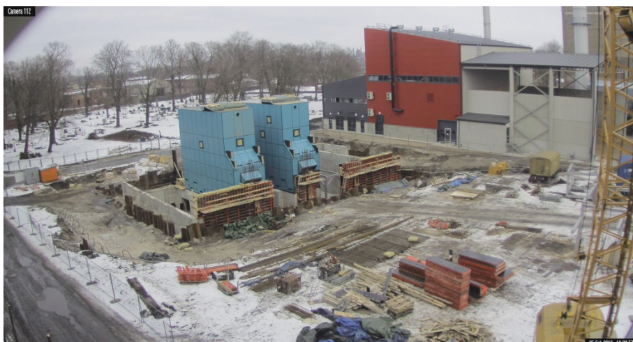
10.attēls. Siltumavota rekonstrukcija koģenerācijas stacijā Kaiju ielā 33 (autors: SIA „Liepājas enerģija”)
