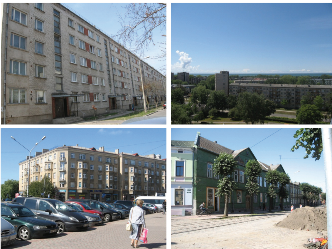
16.attēls. Dzīvojamās ēkas Liepājā
