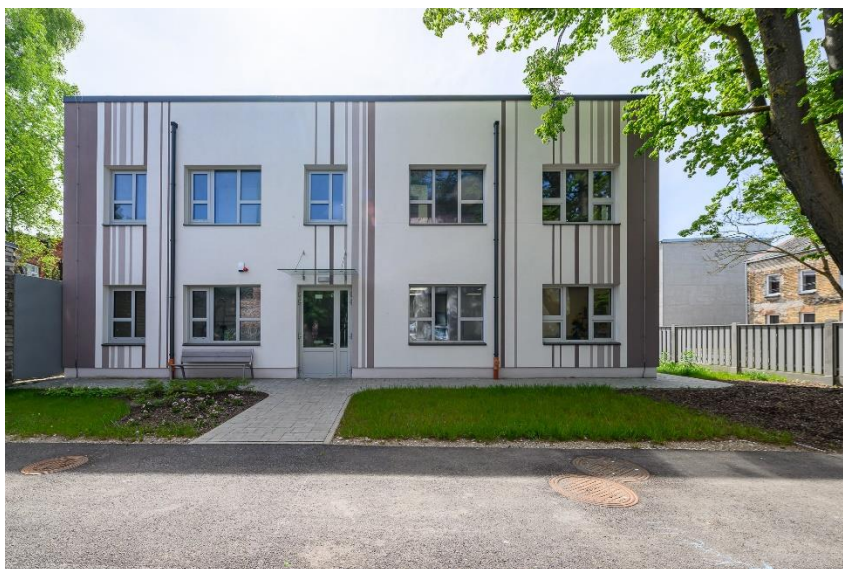
Attēlā: Specializētās darbnīcas cilvēkiem ar GRT T.Breikša ielā 16/20
