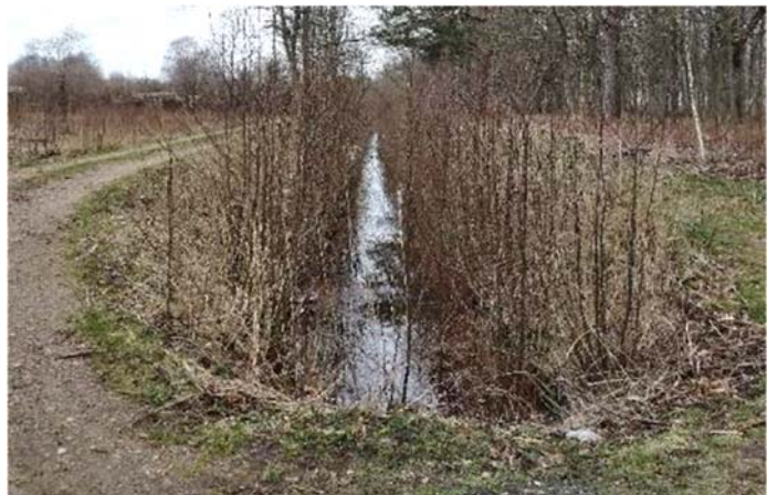
ATTĒLS 21. Novadgrāvis N-4 Lokālpilnojumā teritorijas ziemeļu daļā
